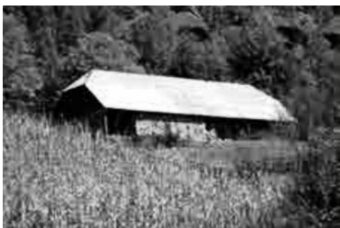
Casa din Prihodiște. Vedere dinspre sud-vest (Sept. 2013)
